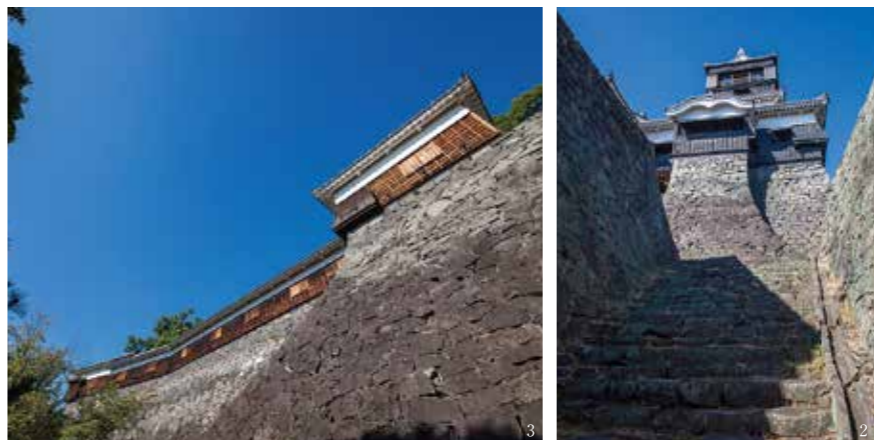
(1)「二層の石垣」。右は清正が築いた石垣で「扇の勾配」と称される。左は細川時代に増築されたもので、技術の進歩により勾配が急になったことが分かる (2) 小天守から続く階段は11頁の石門へ出る抜け穴へと続く。小天守は豊臣秀頼を迎え入れるために建てられたという説が伝わる (3) 手前から四軒櫓、十四軒櫓、七軒櫓、田子櫓。現存する櫓の一部で、いずれも国の重要文化財 (4) 石門の壁に刻まれた文字。永禄17年は西暦1704年。修復に当たった者が彫ったのであろうか
