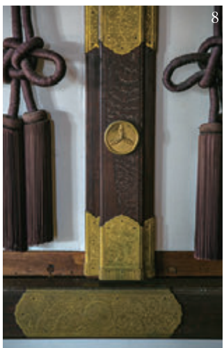
(5) 藩主の居室。上段の間には「武者隠し」が設えてあり、有事に備えた (6) 天守最上階から眺めた高知市内。文久2年(1862年)3月、この城下町を出発して、坂本龍馬は脱藩したという (7) 藩主の座から見える風景の中に、山内家歴代の墓地が見える設えに、一豊の思いが偲ばれる (8) 室内の装飾に刻まれた山内家の家紋「三つ栴」
